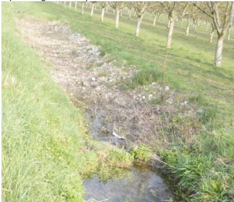
Bassin d'infiltration de la Cascade
