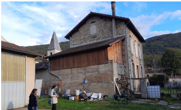
↑ Façades ouest avec les apprentis
