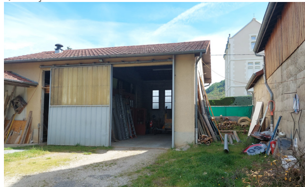
↑ Façade sur cour des ateliers
