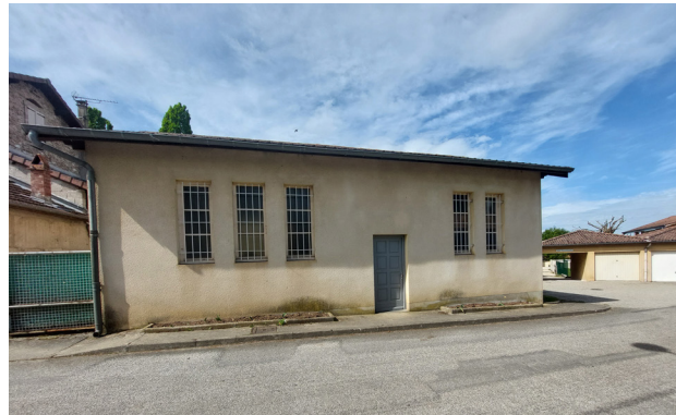
↑ Façade sur rue des ateliers
