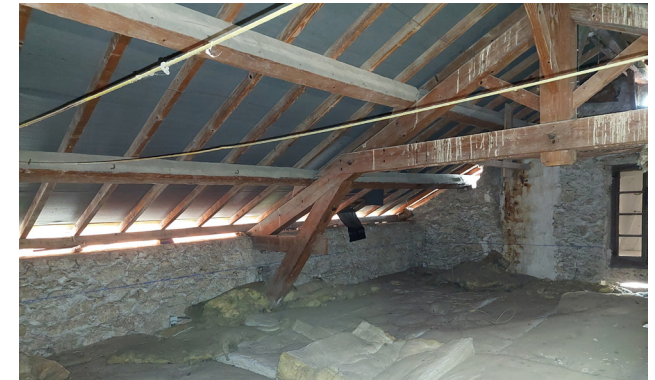
↑ Vue intérieure des combles
