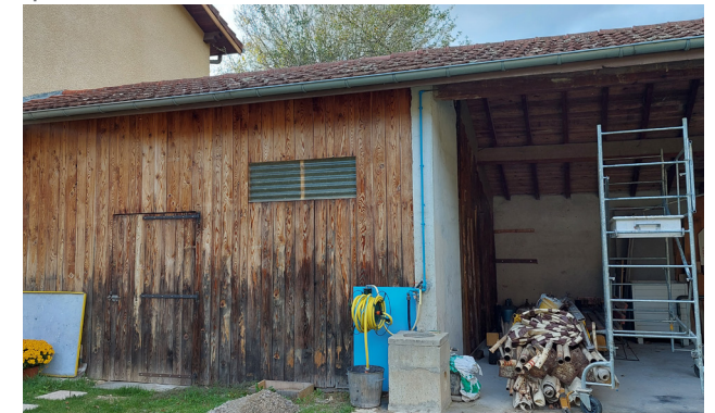
↑ Façades des préaux sur cour
