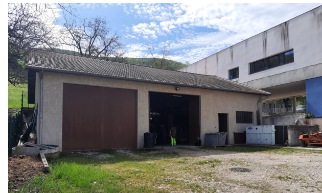
↑ Façade ouest des garages sur cour
