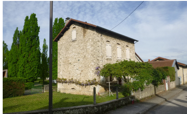
↑ Façades est du presbytère et jardin
