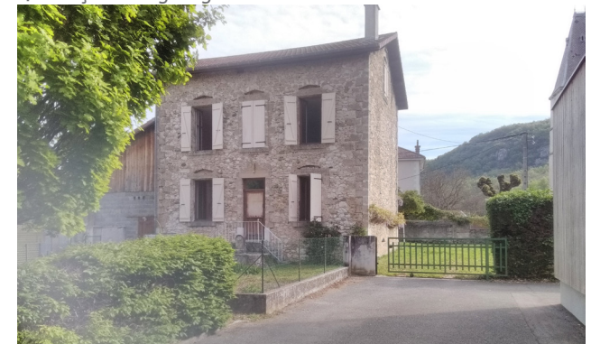
↑ Façade nord-est sur rue du presbytère
